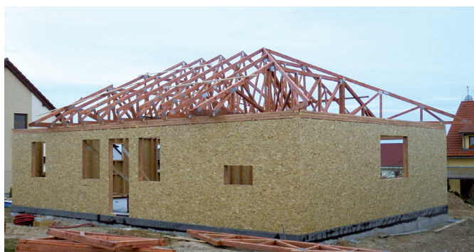
Obr. 5 Výstavba rodinného domu z dřevěné konstrukce
