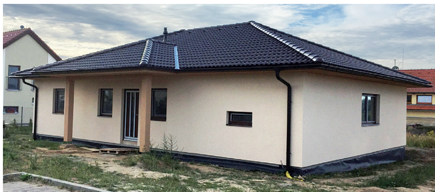
Obr. 7 Dokončená výstavba rodinného domu – dřevostavby
