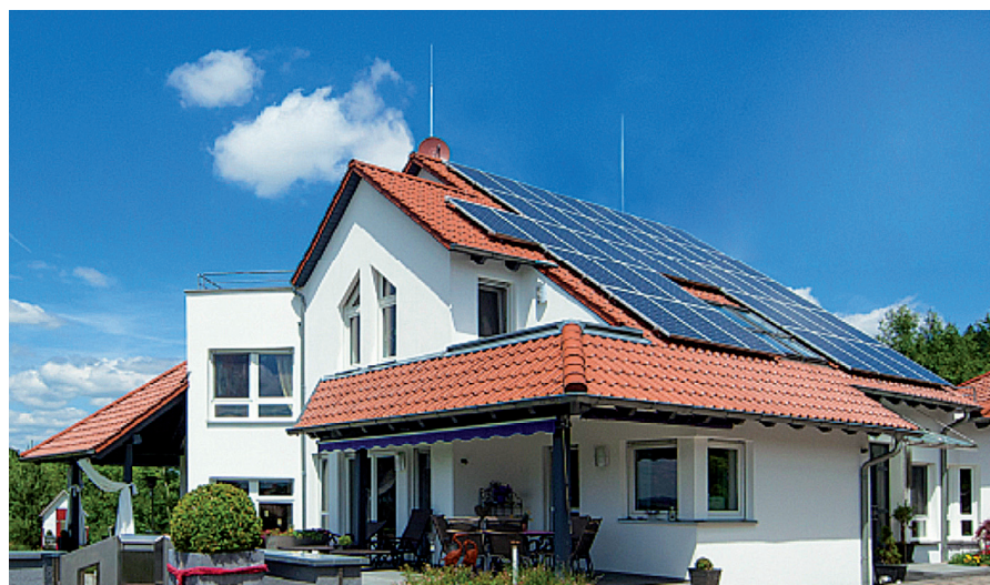
Obr. 11 Izolovaný hromosvod na rodinném domě
