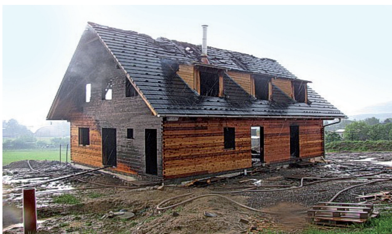
Obr. 2 Pohled na vyhořelou dřevostavbu
