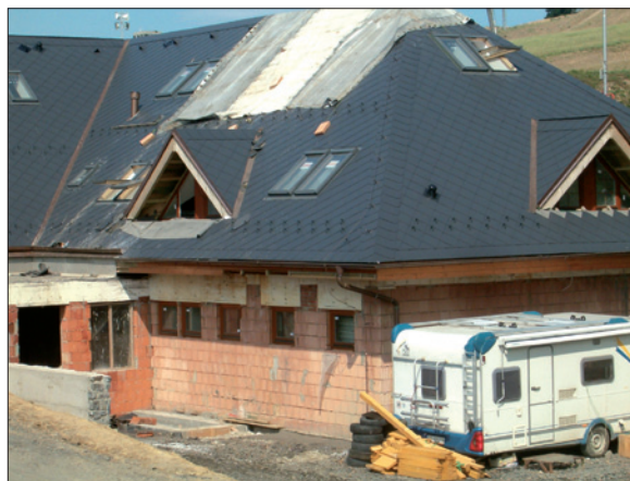
Obr. 6. Situace po uhašení požáru
