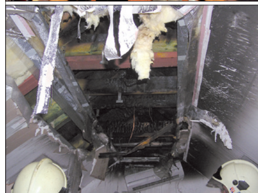
Obr. 2. Zahoření podkroví hotelu
