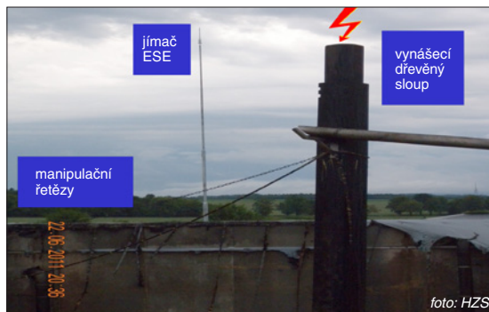
Obr. 3. Poškozená technologická část fermentoru po úde- ru blesku do ochranného prostoru jímače ESE
