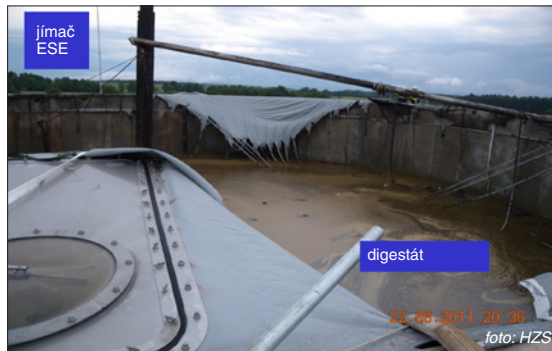
Obr. 6. Pohled do poškozené vnitřní jímký fermentoru, která se celá nachází v ochranném prostoru jímače ESE
