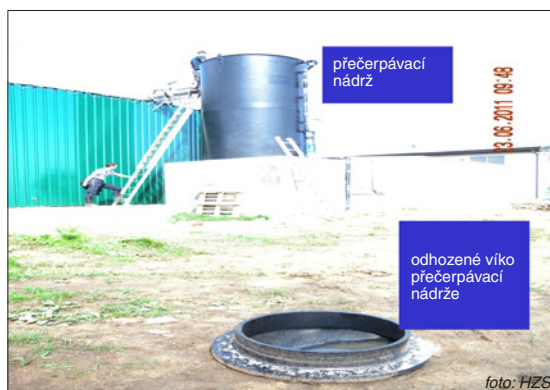
Obr. 5. Odhozené víko přečerpávací nádrže po výbuchu směsi
