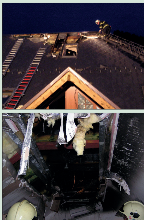
Obr. 2. Zapálení stavby průchodem bleskového proudu její hořlavou konstrukcí
