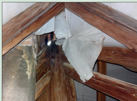
Obr. 4. Úder blesku do chráněné části aktivního jímáče ESE
