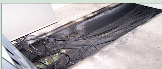
Obr. 3. Vnitřní kabeláž bioplynové stanice po požáru
